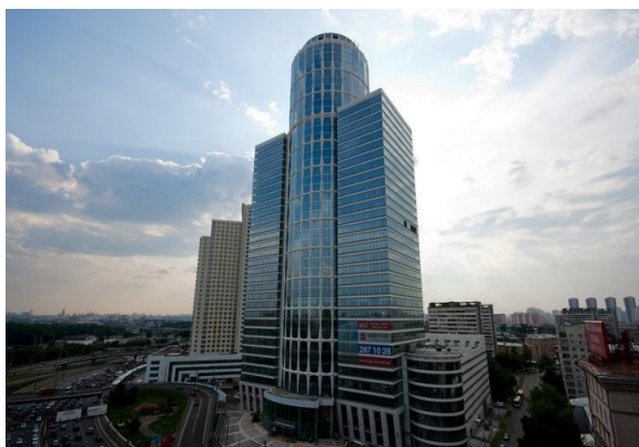
FIGURA 11. Deutsche Bank's oficinas en Moscú, LEED-CI, Gold, 7601 m 2
