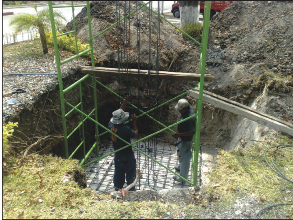
Cimentación. Foto del autor.
