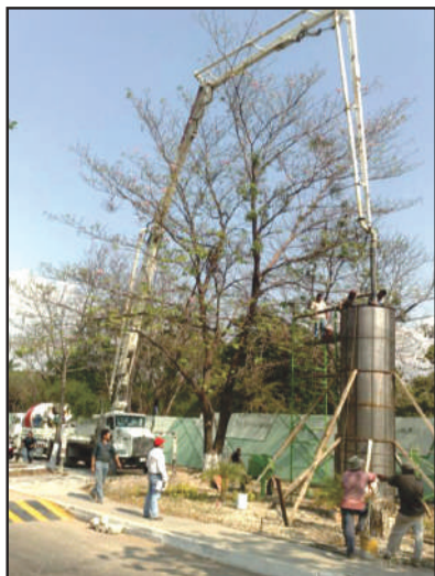
Colado de la columna. Foto del autor.
