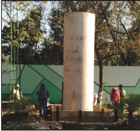
Obra civil concluida, Foto del autor.
