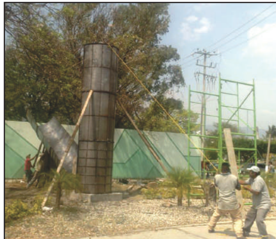
Colocación de la cimbra. Foto del autor.
