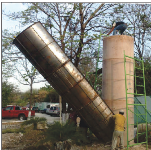
Descimbrado. Foto del autor.
