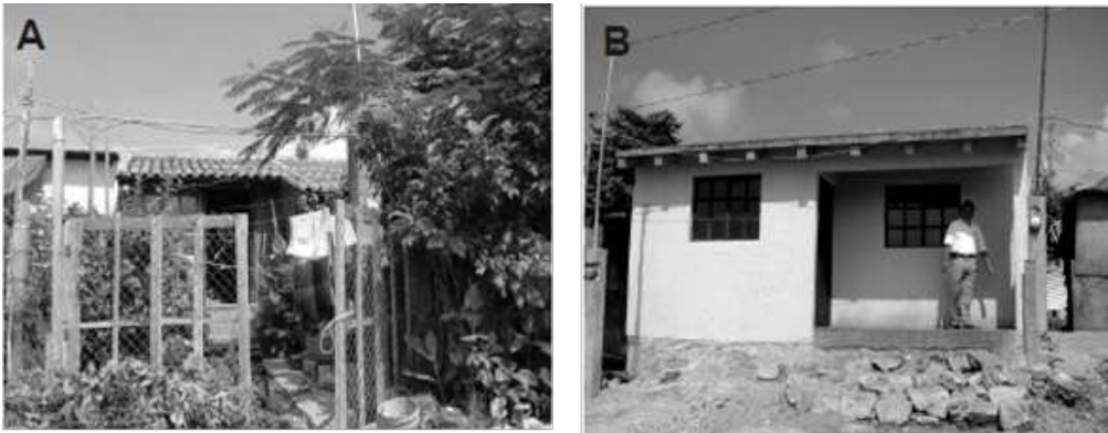
Figura 1.35. Construcciones del programa 10x10 Chiapas. En la foto A, vivienda de bajareque, cubierta con teja de barro, tipo española sobre cama de madera y el filtro asfalto, Propuesta por INVI. En la foto B, vivienda cubierta con la primera versión de sistema adaptado, Universidad Autónoma de Chiapas, México.
