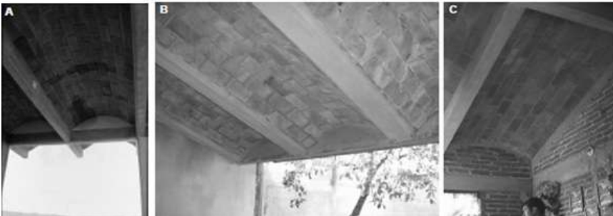
Fig. 2.12- Bóvedas de ladrillo trabajando a compresión aplicadas en techos de vivienda. En la imagen A, Arq. Mario E. Yáñez. En la foto, B, Arq. José Luis Jiménez A. En foto C, Arq. Artemio Gallegos, las tres viviendas en Tuxtla Gutiérrez, Chiapas.
