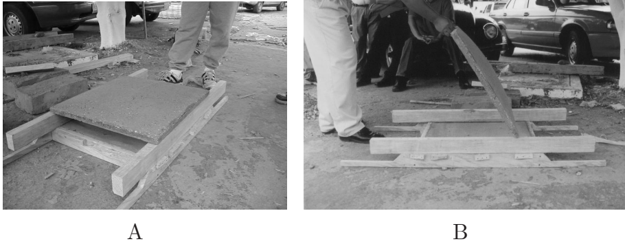
Figura 1.18. Tecnologías presentadas en el Taller de Transferencia de Tecnología de Chiapas. En la foto A se muestra un componente para techo Domozed, en la foto B, parte del Domozed después de 12 horas.
