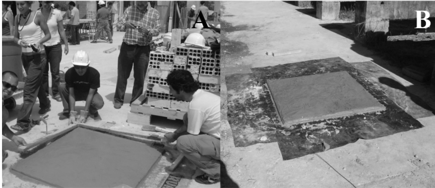
Figura 3.14. Foto A, al terminar de colocar el mortero sobre el petatillo se retira la forma de madera, que se puede utilizar nuevamente. Foto B, la pieza Domotej completada en curación.
