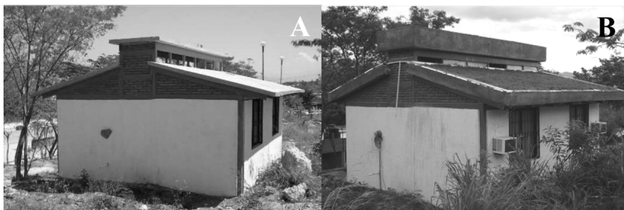
Figura 3.40. Sistemas de techo Domotej antes (foto A) y después (fotoB) de complementar el techo verde, construido en un terreno de la Facultad de Arquitectura, UNACH.
