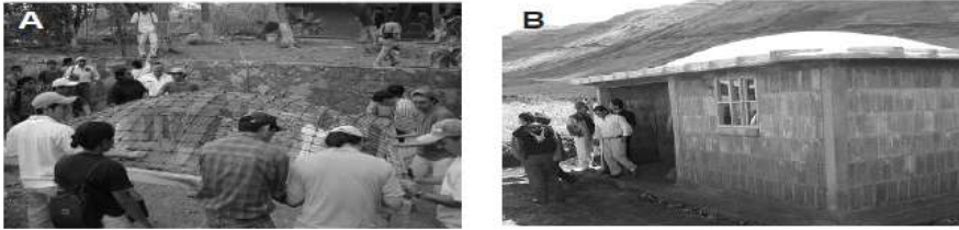
Figura 1. 3. La foto A, sistemas de techo Cúpula mortero armada en el taller 10x10 Chiapas. Ing., Luis Leyva. En la foto B, los sistemas de techo Cúpula mortero armada en 10x10 Ecuador.
