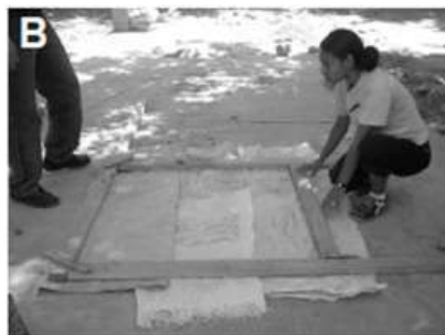
Figura 3.8. Foto A, cimbra de madera para el Domotej, en planta. En la foto B, forma de cimbra colocada sobre lona plástica para fabricar un Domotej.
