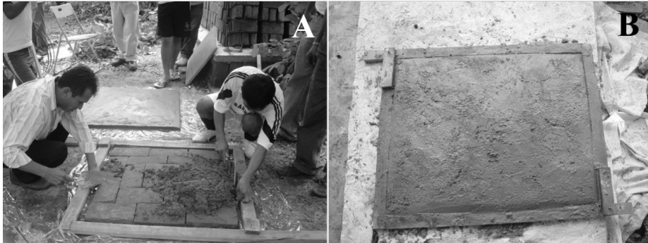
Figura 3.13. Foto A, colocación de mortero cemento-arena 1:3 sobre el petatillo, foto B, Cubierta de 1.00 cm mortero con un espesor de 1 cm.
