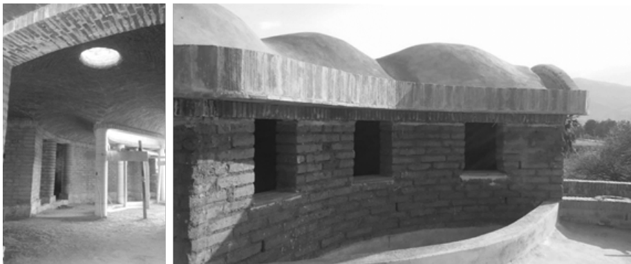
Fig. 2.8 Bóvedas de ladrillo sobre muros de adobe, en Casa habitación, Oaxaca, Oaxaca, Arq. Ramón Aguirre Morales.
