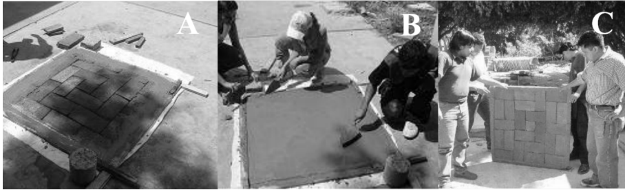
Figura 3.34. En las fotos A, B y C. Se muestra parte del proceso de fabricación de un componente del sistema de cubierta “Domotej” preparado en las instalaciones de la Escuela de Arquitectura de la Universidad Autónoma de Chiapas, México.
