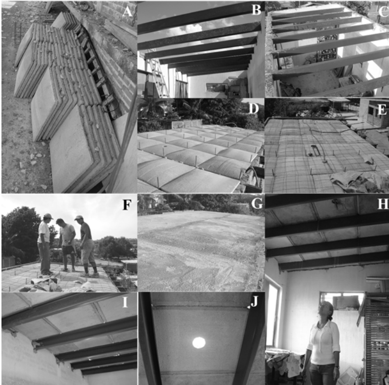
Figura 7.3. Proceso de construcción de techo Domozed, de la foto A hasta la foto J, se observa el proceso sucesivo de fabricación del techo.
