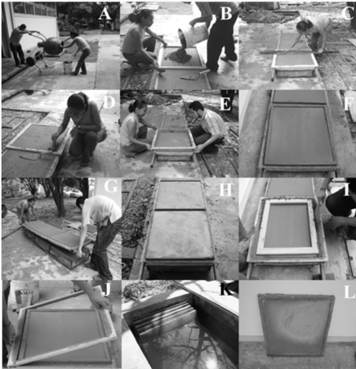
Figura 3.2. Proceso de pre - fabricación de componentes para el techo Domozed, de la foto A hasta la foto F, se observa el proceso de fabricación de componente Domozed.
