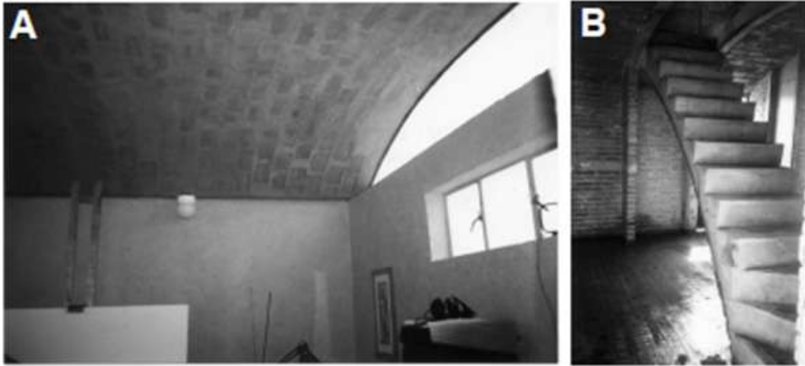
Figura 2.11-. Bóvedas de ladrillo, Arq. Mario Larrondo. Foto A y B, Vi- vienda en la Ciudad de México D. F.
