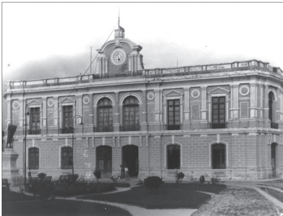
FIGURA 5. PALACIO DE GOBIERNO DEL ESTADO EN 1905. SALA TUXTLA (2020).
